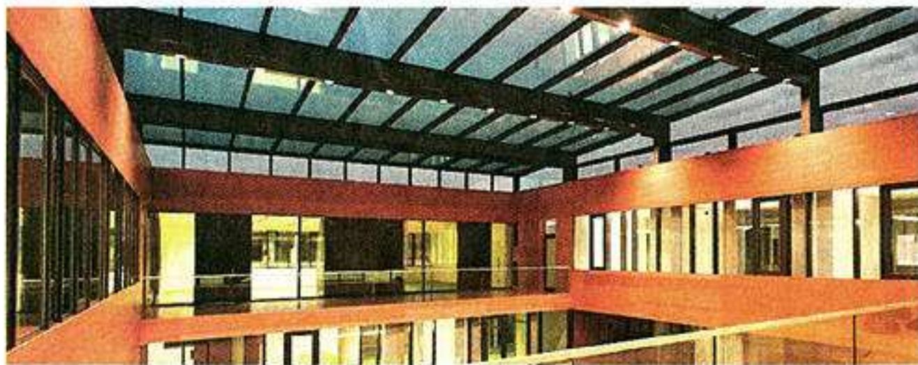
...sowie eine Photovoltaikanlage auf dem Dach.
