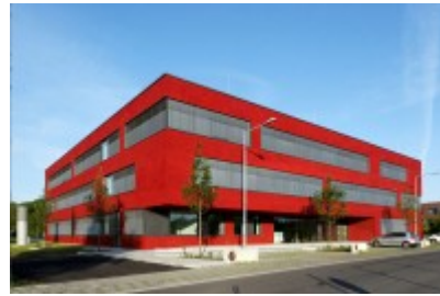
[+] Das dreigeschossige Atriumhaus "etrium" (Energieeffizienz + Atrium) von Benthem Crouwel (Aachen) ist ein nachhaltig konzipiertes und energiesparendes Bürogebäude in Passivhausbauweise, das ohne ohne konventionelle Heizung und Klimaanlage auskommt. Foto: Manos Meier
