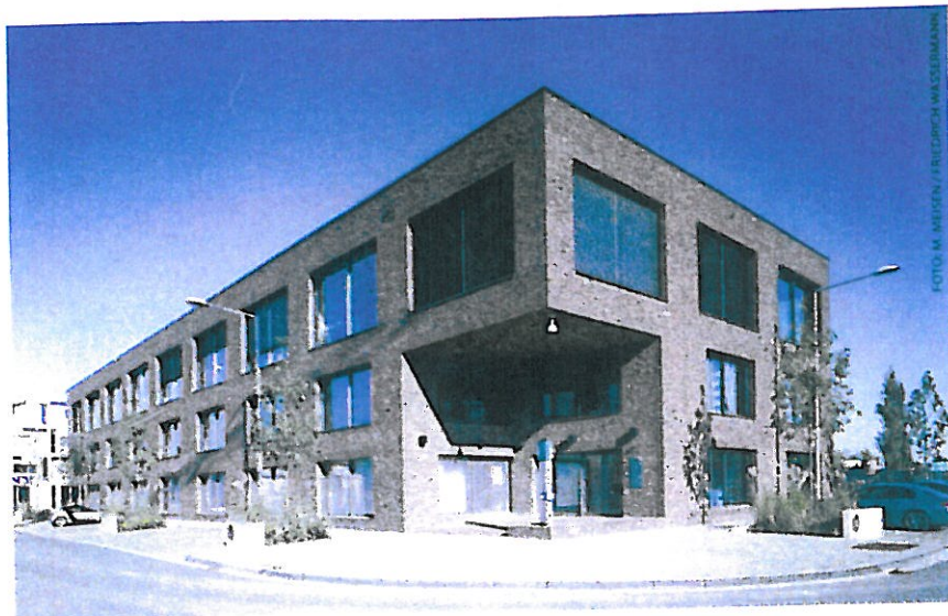
Im Wachstum: Weil der Mieter mehr Platz braucht, bekommt das Büro- und Logistikgebäude Alpha Eins nun eine zweite Hälfte namens Alpha Zwei.
