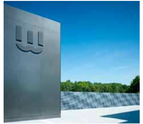
Wassermannhaus, Schilling Architekten, Köln,
