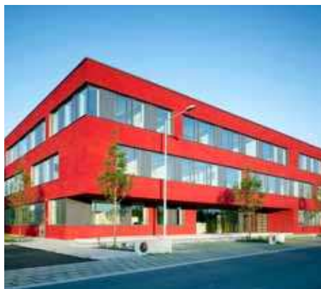
atrium, Benthem Crouwel Architekten, Aachen/Amsterdam
