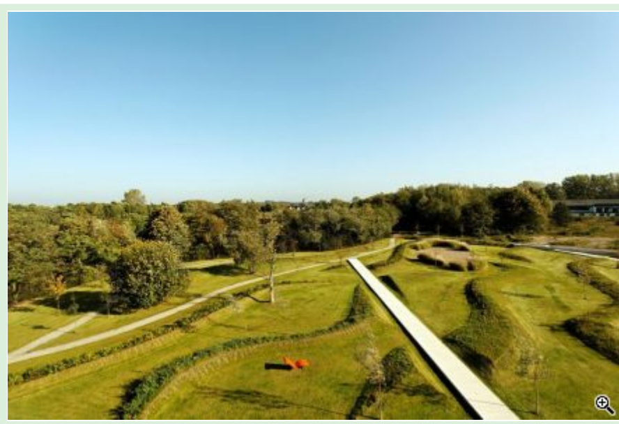
Arbeiten mitten im Grünen - Der Wassermannpark ist rund 8.500 qm groß.jpg
